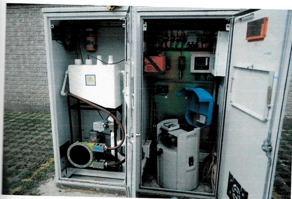
Estación de medición de calidad de vertidos (izq) con muestreador automático (der)
